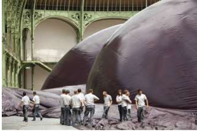
Şekil 12 - Anish Kapoor “Leviathan”, (çalışma yerleştirme aşaması)
